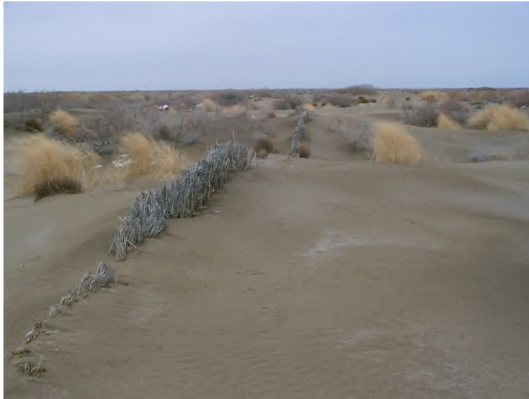
Устройство стоящих мехзащит из камыша
