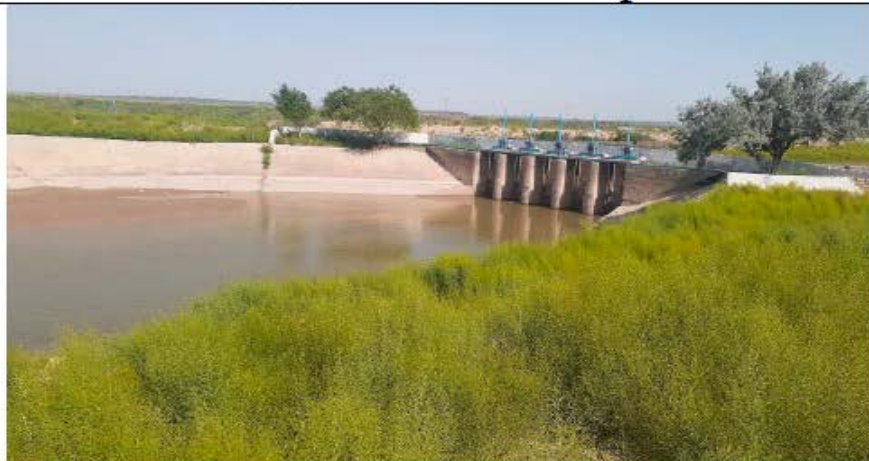
Вид с верхнего бьефа
