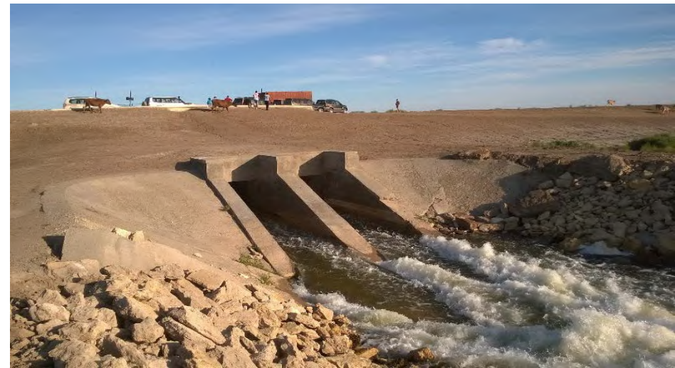
Водовыпуск-водосброс на ПК22 «Рыбачьего водохранилища», 10 м 3 /сек
