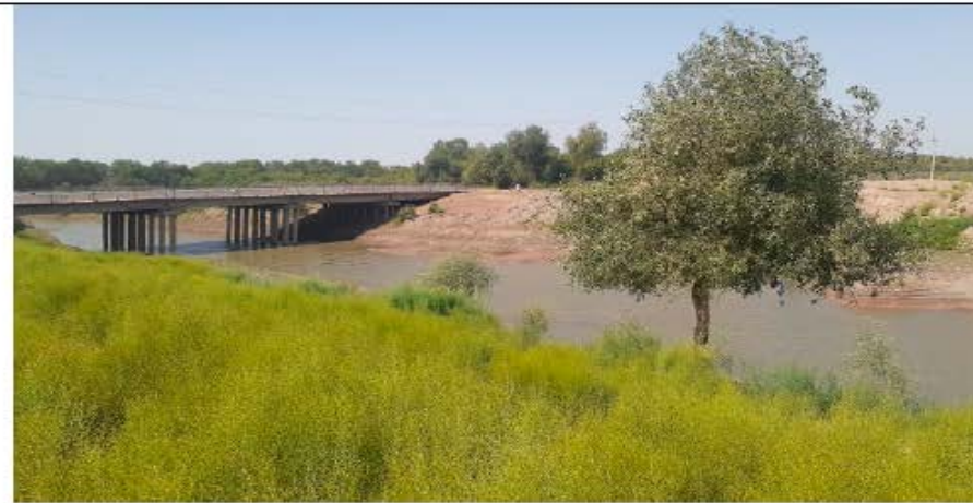
Подводящая часть – мост на дороге Муйнак - Порлытау
