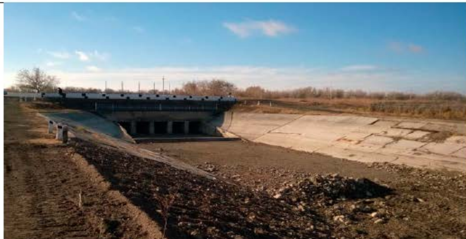
Вид с нижнего бьефа
