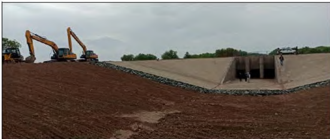
Канал Талдык вход в дюкер
