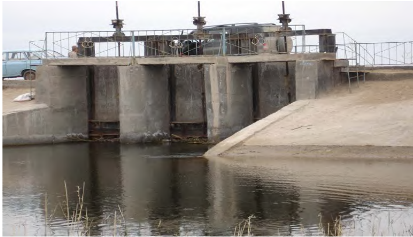
Джилтырбасский залив. Водовыпуск-водосброс на 30\text{ м}^3/\text{с} ПК240. Год ввода в эксплуатацию 2003г. Стоимость объекта 132626,0 т.с.
