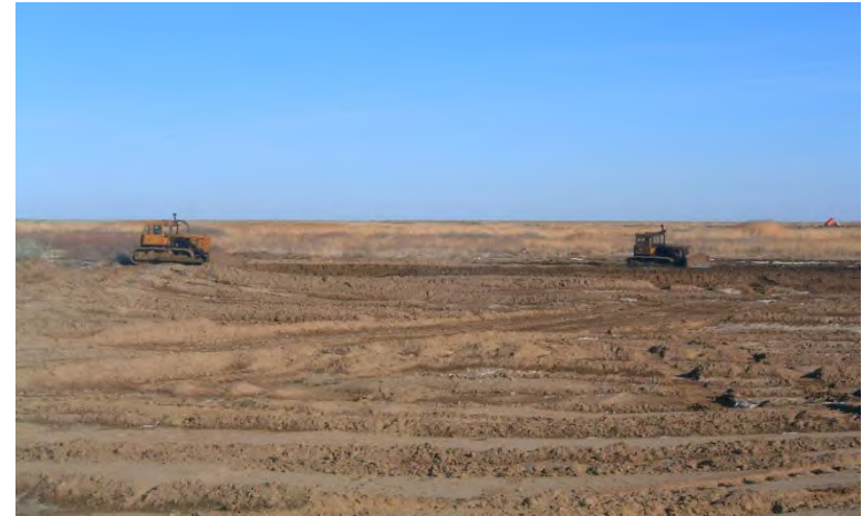
Строительство дамбы Джилтырбасского водохранилища, расчистка основания дамбы от кустарников
